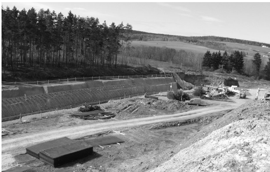
Obr. 1, 2. Pohled z vrcholu skrývky materiálu na západní část lineární stavby železničního tunelu mezi obcemi Osek a Újezd u Hořovic. Foto V. Vokáč, březen 2010.
