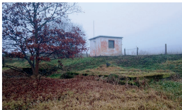
Obr. 4 – Vodárna v místě ústí štoly. Foto P. Mikota 2020.
