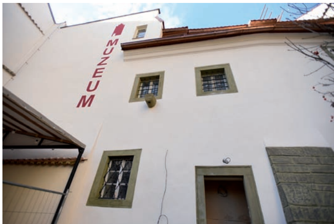
Postup prací při rekonstrukci Národopisného muzea Plzeňska
