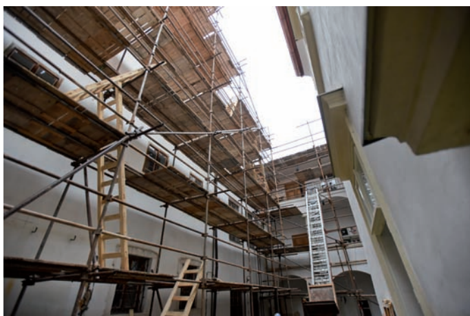
Postup prací při rekonstrukci Národopisného muzea Plzeňska
